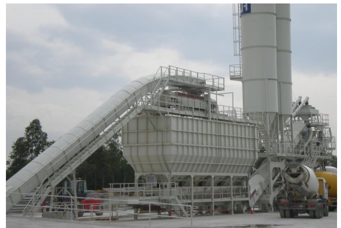
INGENIERIA, FABRICACION Y MONTAJ PLANTA CEMENTERA
